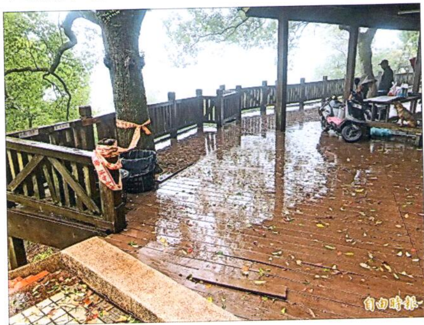
地理中心碑觀景平台僅部分區域拉起封鎖線，平時仍有民眾進入，甚至還有機車，安全堪虞。(記者佟振國攝)
